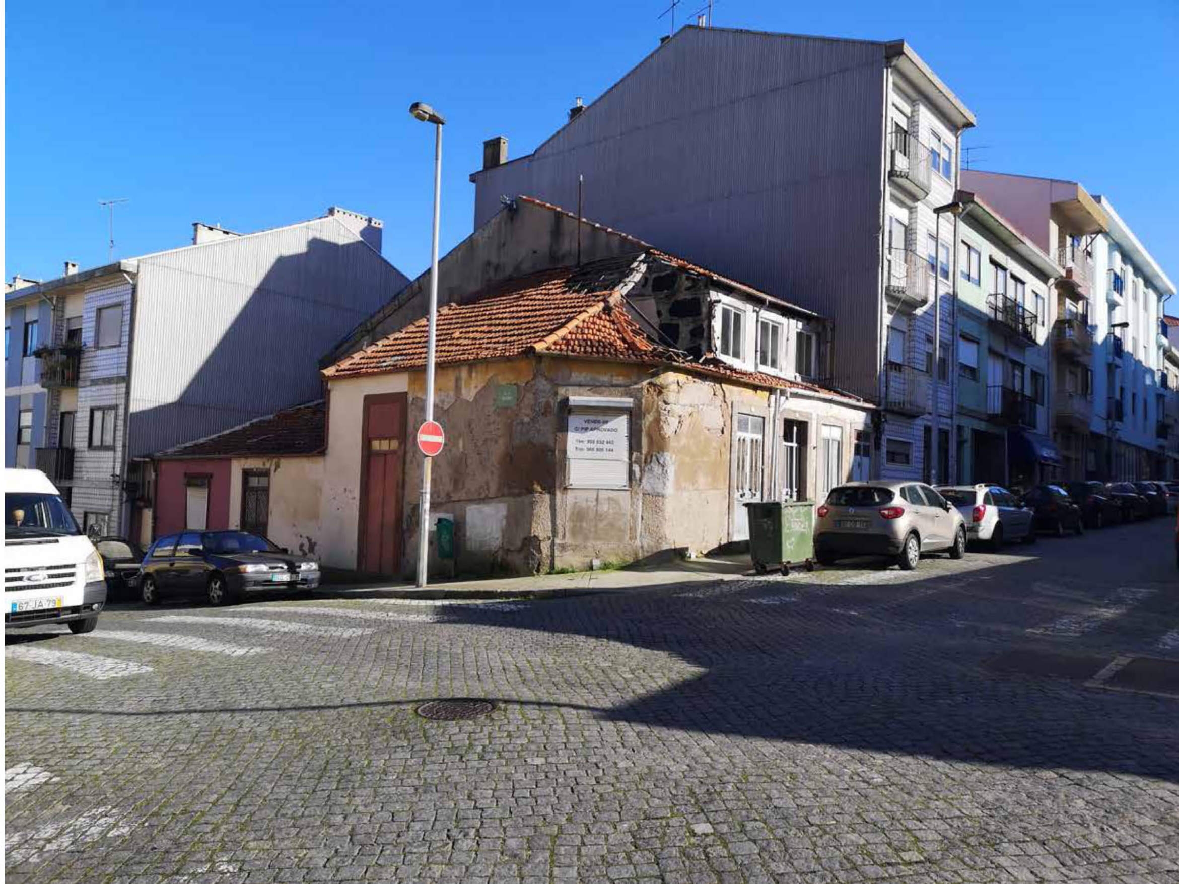
Imóvel existente, sito na esquina das Ruas Monte Alegre e da Aliança
